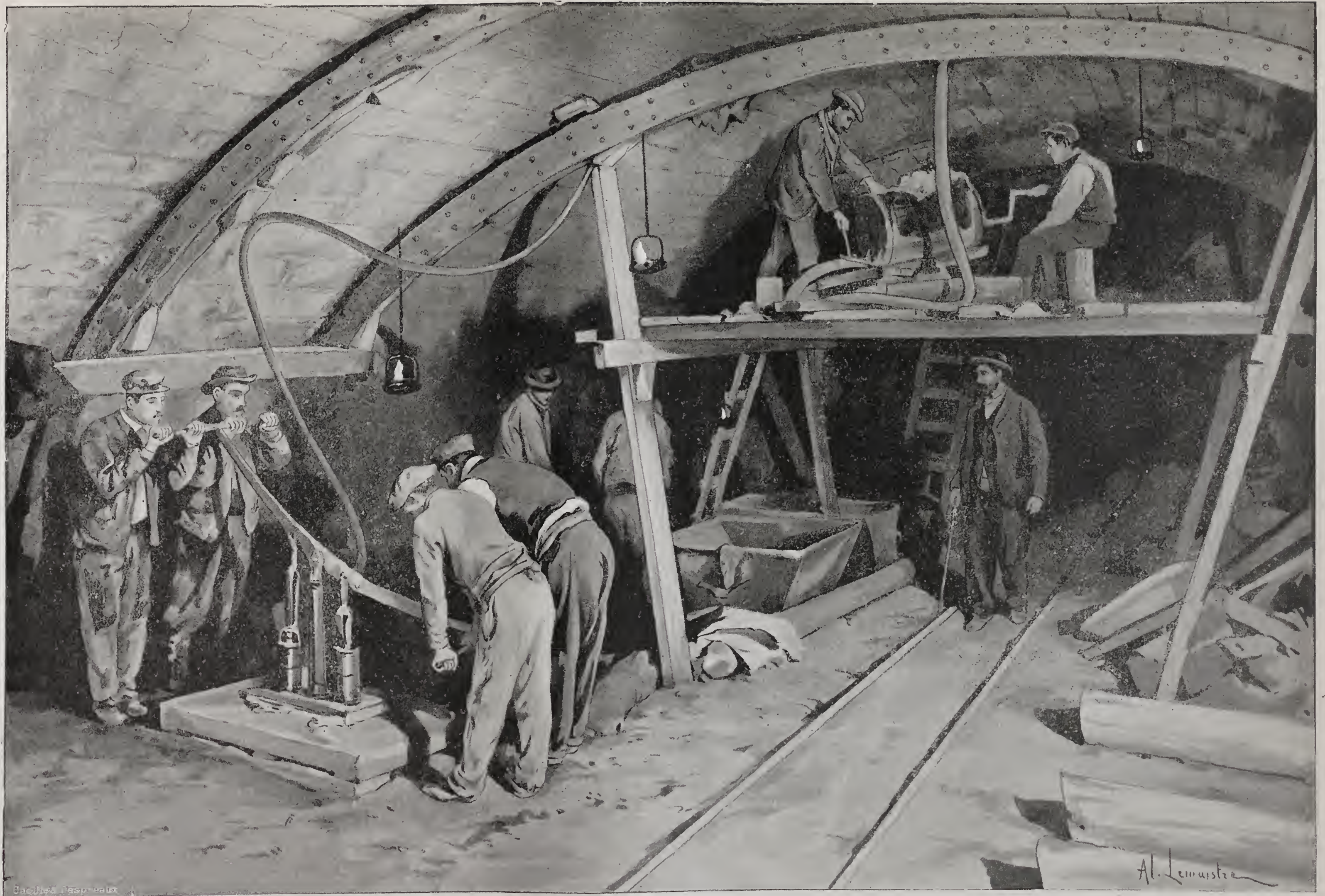
LA LIGNE COURCELLES-CHAMP-DE-MARS. — Injection du ciment sur l'extrados d'une voûte.
